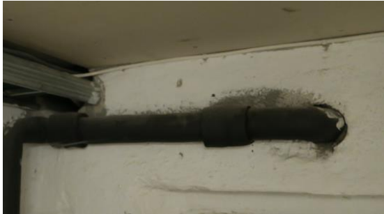
Figur 4 Rør-isolasjon
