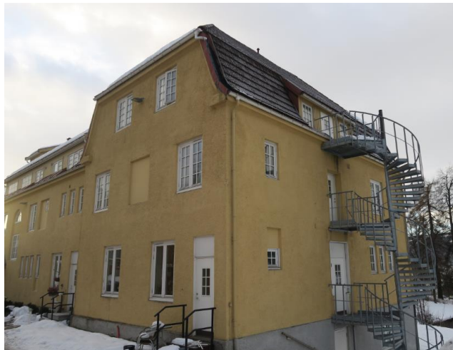
Figur 6 Utvendige overflater og tak
